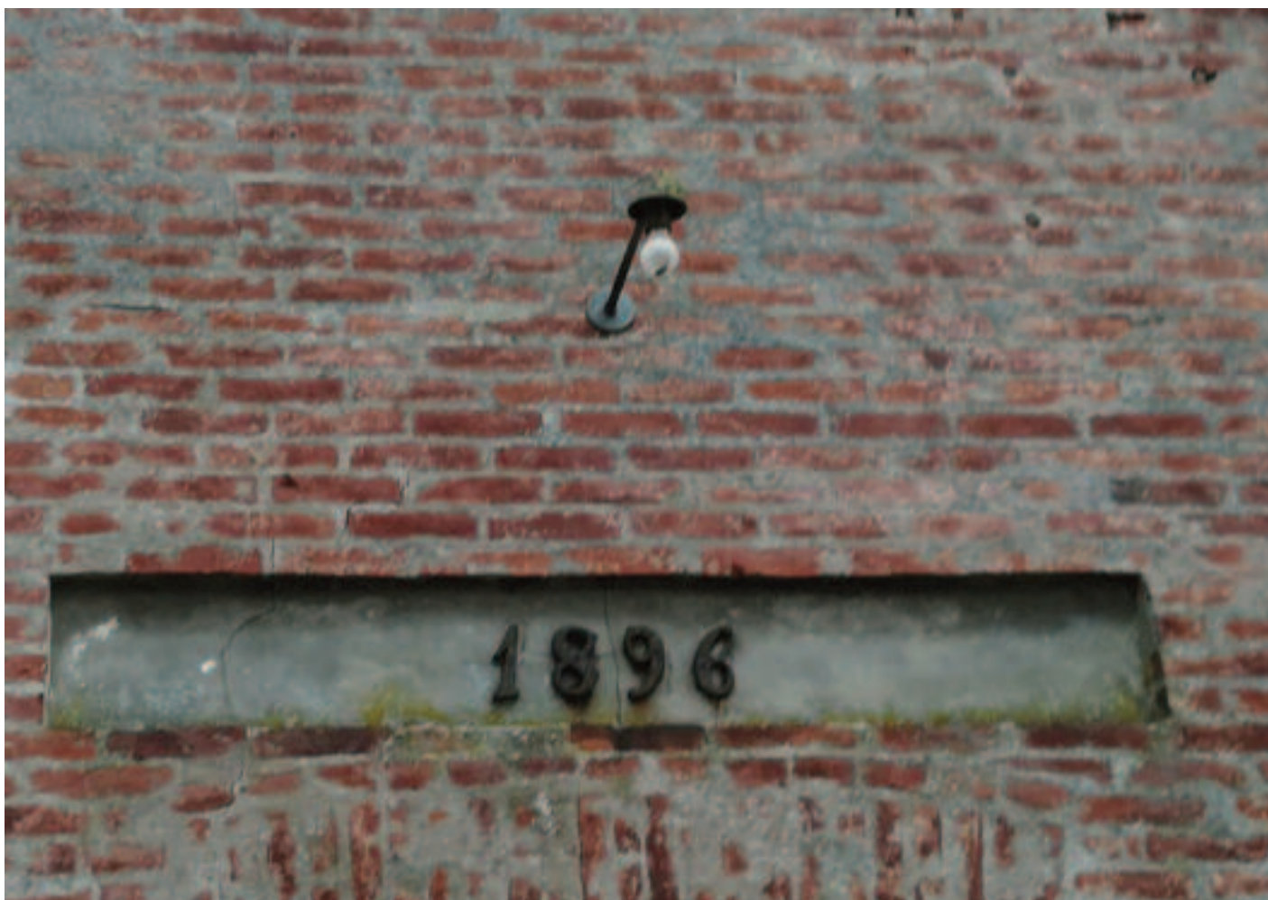
Fra gavlen på Obbekær Forsamlingshus. Stærkt ombygget. (Foto 2019).
